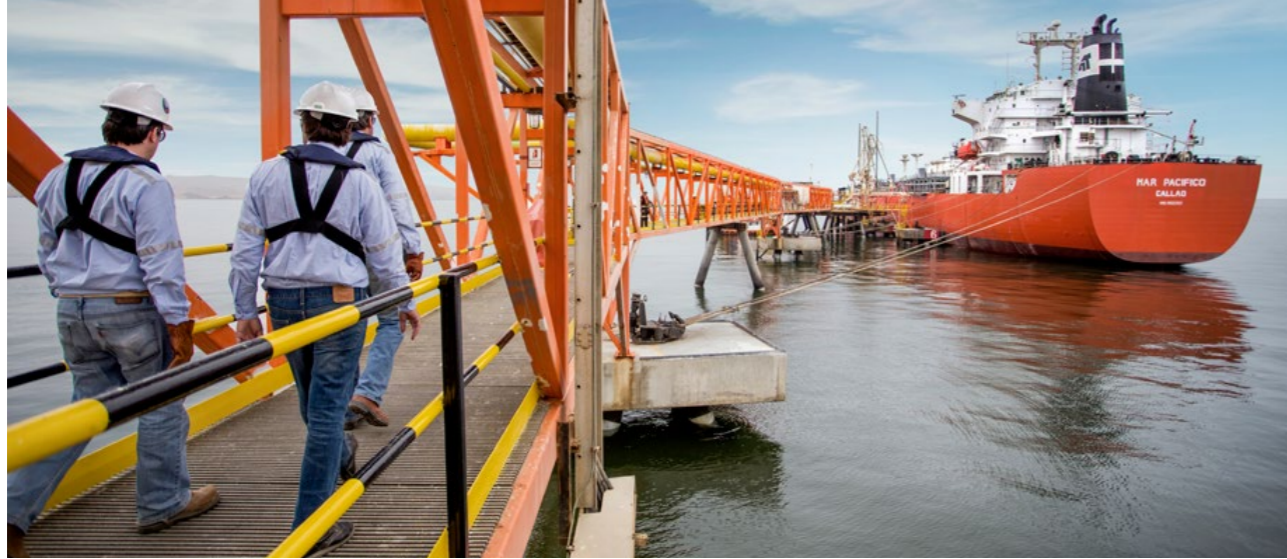
Terminal de carga marítima, Planta Pisco, Perú.
